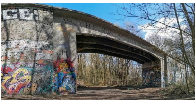
Abb. 1: Ehemalige Eisenbahnbrücke bei Emmering
